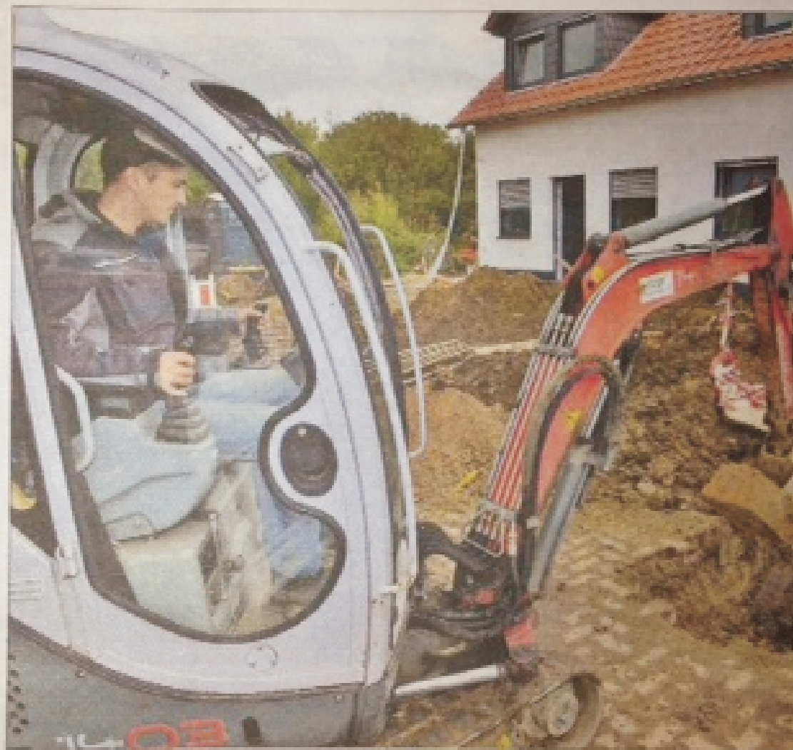
Noch sieht es nicht wirklich nach Krippe aus: Vor dem Haus an der neuen Einrichtung am Heinrich-Heine-Weg baggern Arbeiter noch an den Schächten. Junker
